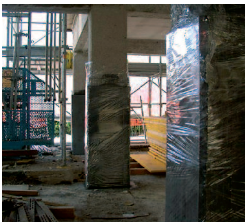
Figura 12 Fase 4 - Completamento cassetteria pilastri e travi con collaggio del micro calcestruzzo fibro-rinforzato dal piano superiore.
