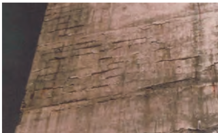
Esempi di calcestruzzo armato degli anni 1950-1960 fortemente deteriorati dopo 25÷30 anni di vita
