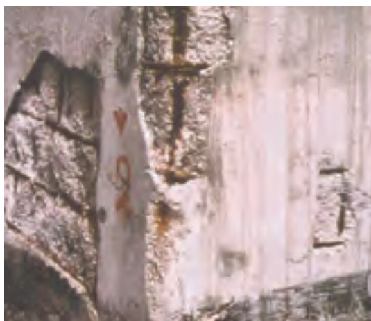
Esempi di calcestruzzo armato degli anni 1950-1960 fortemente deteriorati dopo 25÷30 anni di vita
