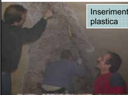
Sarcitura lesione e sigillatura dei bocchigli con malta MuCis® BS 38/39
