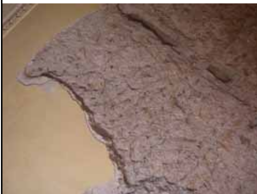
Armatura di sostegno portaintonaco nel soffitto
