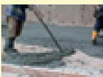
Formazione di una cappa in calcestruzzo avente lo stesso R<sub>cK</sub> della successiva platea, per uno spessore ≥ 5 cm quale protezione del sistema impermeabilizzante. Tale cappa potrà essere omessa su indicazione della D.L. Ogni onere e fornitura compresa.
